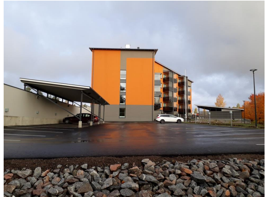
Alikulun läpi kuljettaessa Tykin pientaloalue vaihettuu uuteen rakenteilla olevaan kerrostaloalueeseen.
