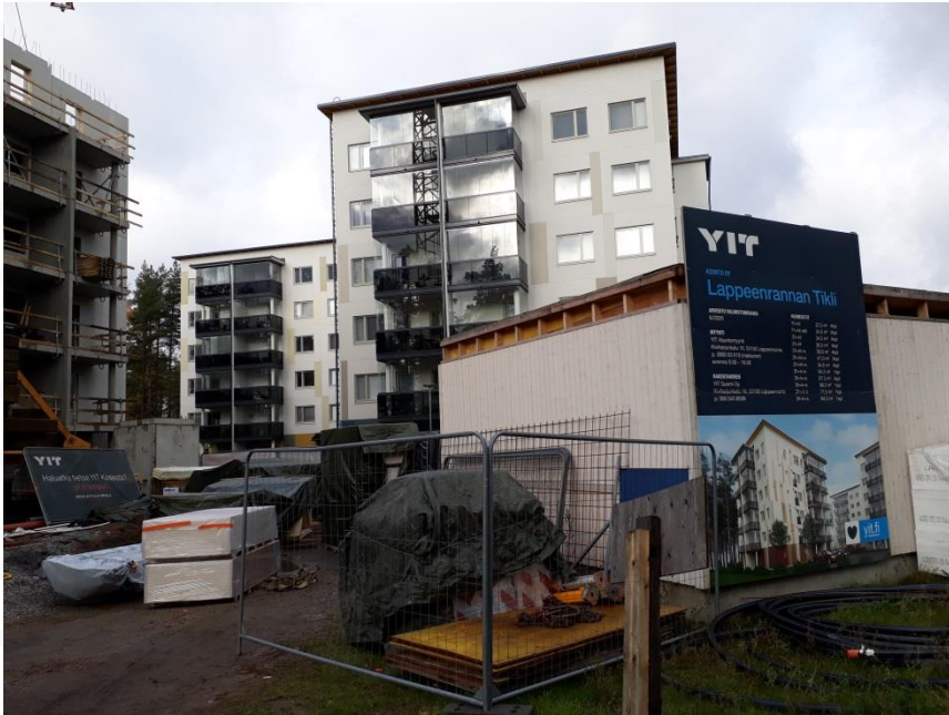
Lepolaan oli lokakuussa 2019 rakenteilla kerrosaloja.
